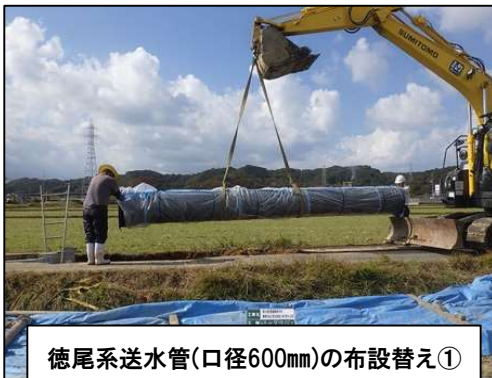
徳尾系送水管(口径600mm)の布設替え②
